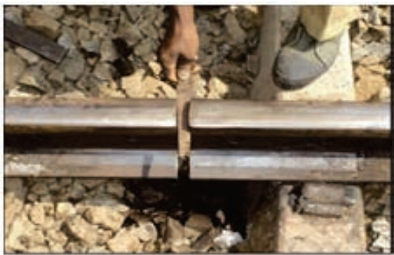
Fig.1.3 Checking Gap
